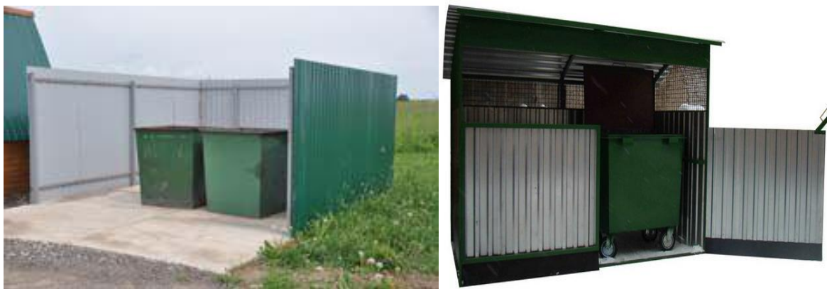
Рисунок 13 – Устройство контейнерной площадки
